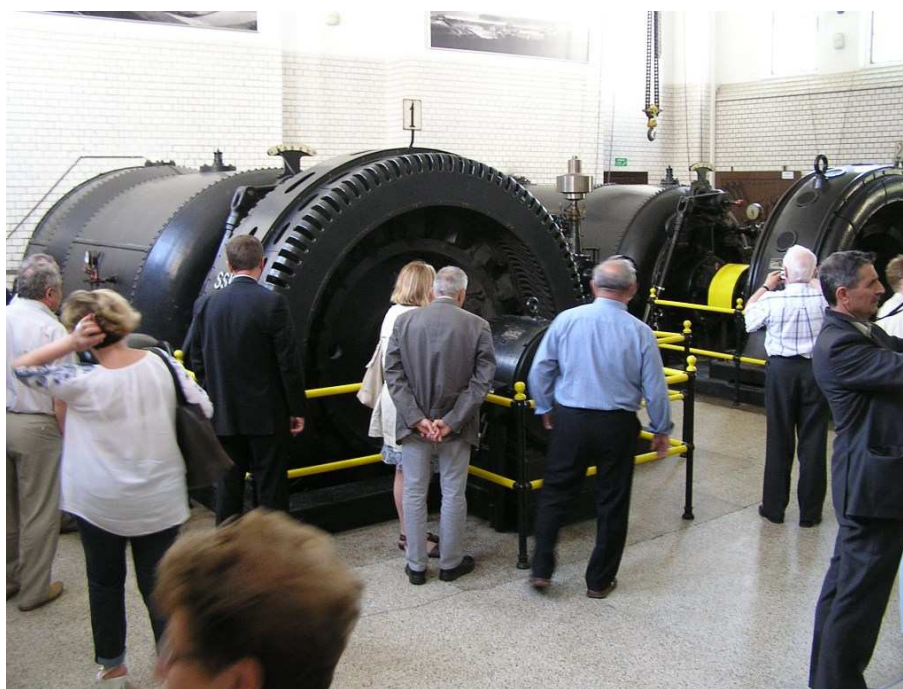
Zwiedzanie wnętrza elektrowni
