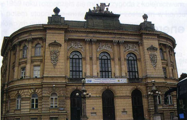
Gmach Politechniki Warszawskiej – miejsce obrad KEP
