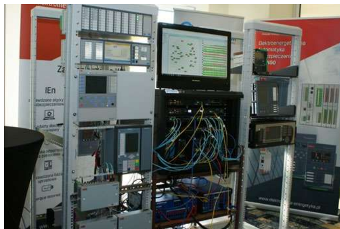
Rys. 10. Stanowisko laboratoryjne demonstrujące współpracę urządzeń na podstawie standardu IEC 61850
